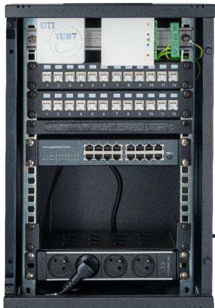
1 - Raccorder la multiprise sur une prise électrique à proximité de la baie ou effectuer un raccordement conforme aux règles d'installation de la norme NF C15-100
