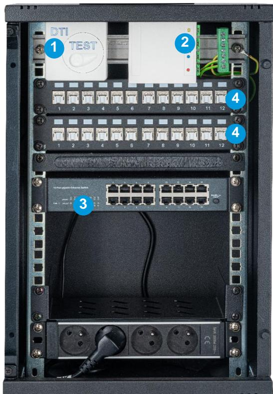
1 - DTI RJ45 (connecteur de test en face avant utilisé uniquement pour le test de la ligne téléphonique)
