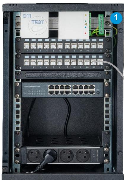
1 - Vérifier la conformité du système de protection (continuité électrique de la mise à la terre) entre la terre générale, le bornier de terre de la baie, et l'ensemble des éléments (masses métalliques, blindages.) y étant raccordés le cas échéant.
