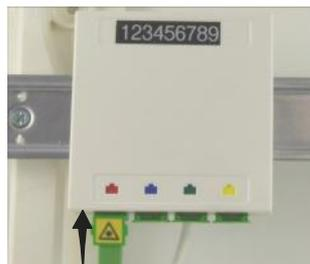
Pour faire les mesures de contrôle ou pour raccorder un appareil au réseau optique, brancher un cordon optique sur une sortie du DTIo.
