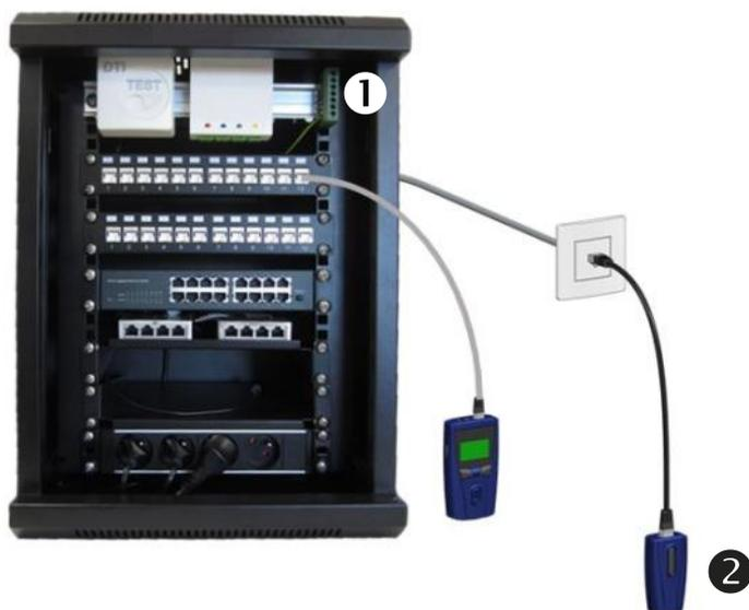
1 - Vérifier la conformité du système de protection (continuité électrique de la mise à la terre) entre la terre générale, le bornier de terre de la baie, et l'ensemble des éléments (masses métalliques, blindages...) y étant raccordés le cas échéant.
